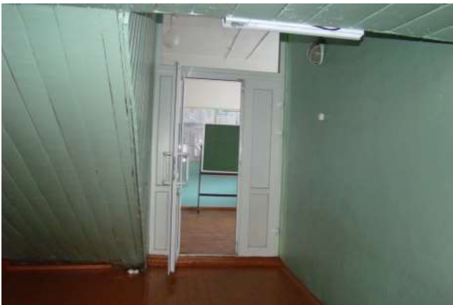
Фото 3: коридор, путь движения внутри здания
